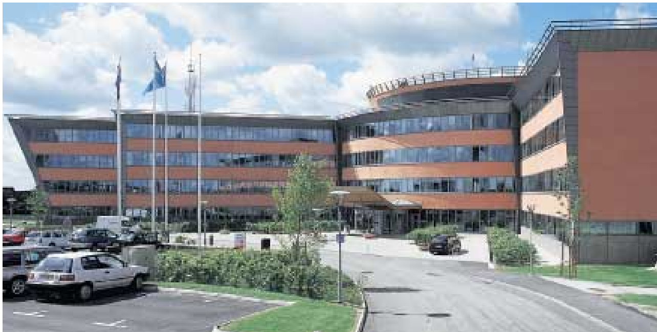
Fastigheten Nya Vattentornet 2 i Lund köptes i juni. Fastigheten, som byggdes 1996–99, är på 27 690 m 2 och ligger i Lunds expansivaste område, IDEON-området.
