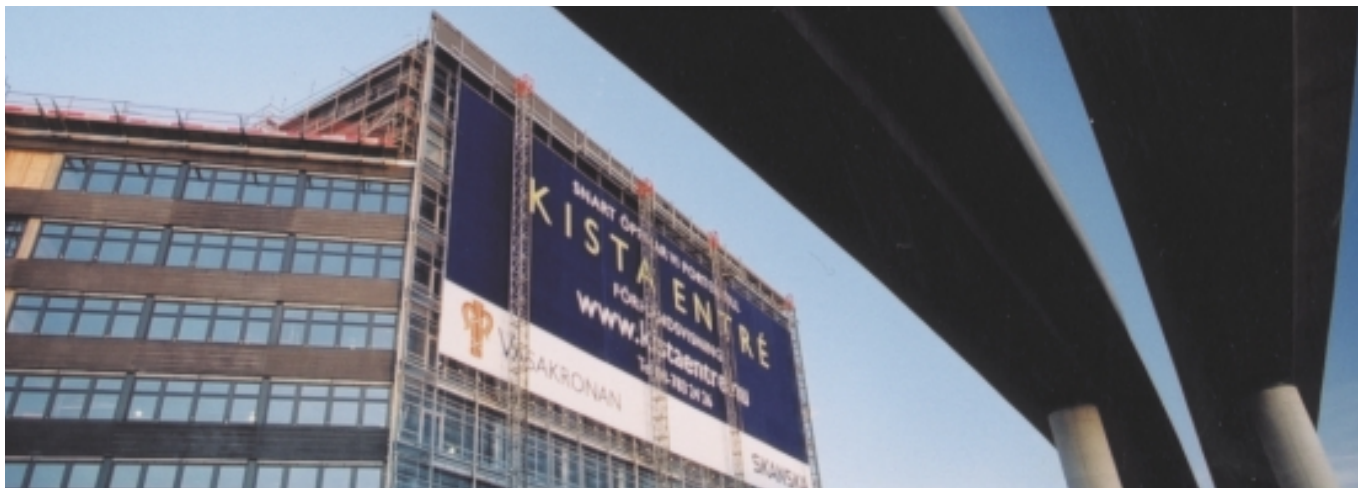
Under 2003 tillträder Vasakronan två nyproducerade fastigheter i Kista. Kista Entré köps av Skanska med en hyresgaranti. Option finns att förvärva resterande 50 procent av Kista Science Tower från NCC efter marknadsvärdering.
